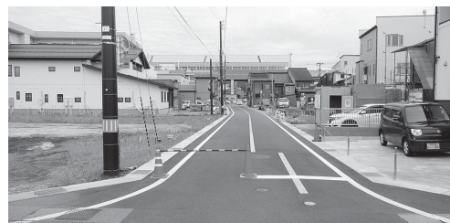
写真-3 拡幅前(幅員約3m)と拡幅後(幅員約6m)
